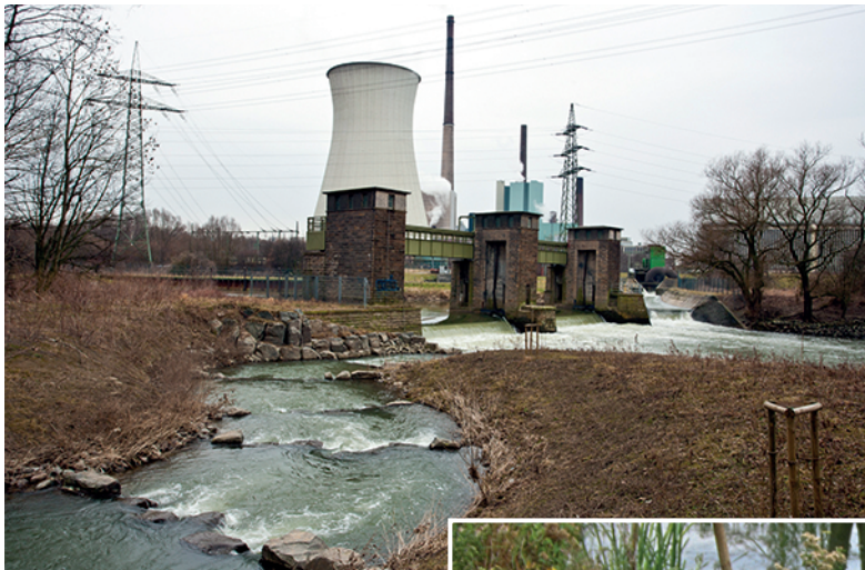
Wehr Lünen-Buddenburg, unterer Teilabschnitt des Fischeaufstiegs
