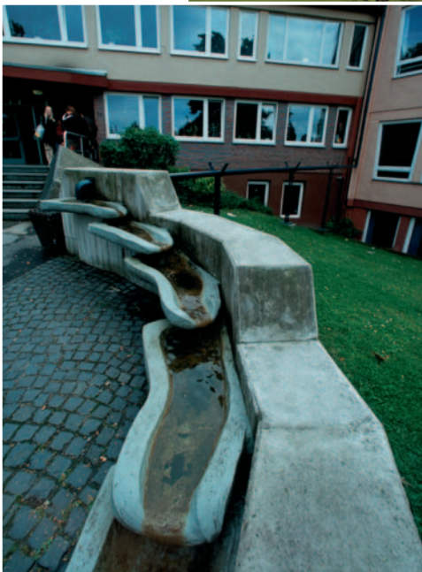
Regenwasserversickerung an der Hiberniaschule in Herne
