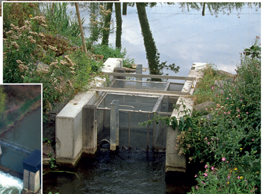
Reusen im Einlaufbauwerk
